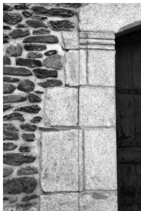
Església de Palau. El picapedrer sabia que l'arrebossat amagaria una part del granit
