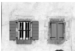
Santa Llocaia. Cal Mateu. Restauració del s. XXI
