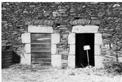
Santa Llocaia. Cal Mateu. L'arc de descàrrega només es podia veure on vivia el bestiar...
