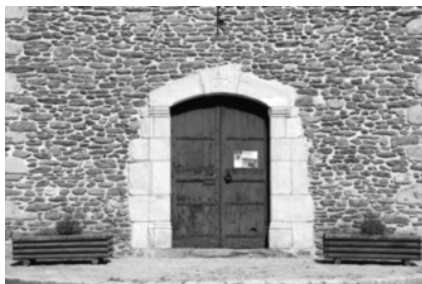
Església de Palau. El picapedrer sabia que l'arrebossat amagaria una part del granit
